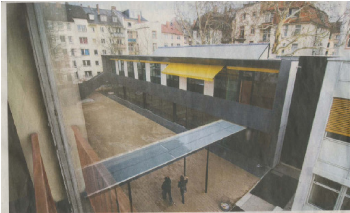
Was zu lange währt, wird auch noch teuer: Mit einem Jahr Verspätung ist die Cafeteria der Helmholtzschule fertig. Sie kostet 1,5 Millionen Euro mehr als geplant. Foto: wab
